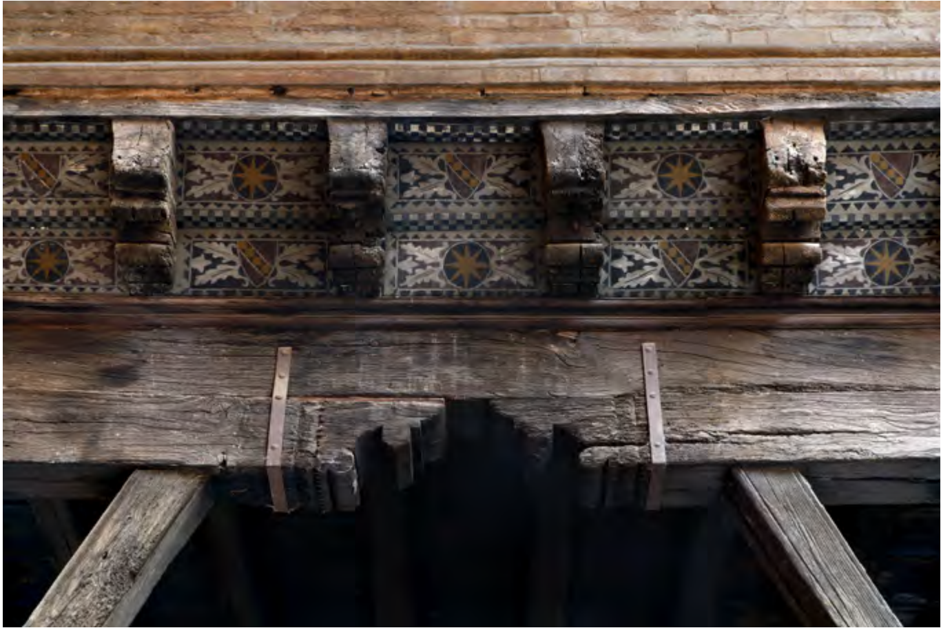
Fig. 60. Particolare del solaio ligneo decorato della casa Azzoguidi, via San Nicolò 2.
