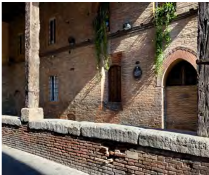
Fig. 13. Particolare del murello della casa Grassi, via Marsala 12.
