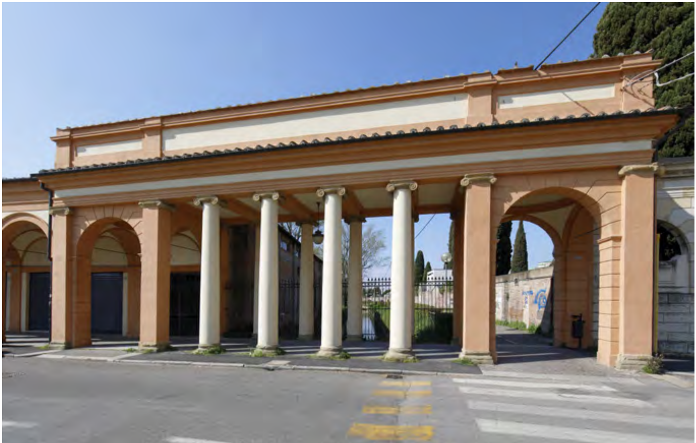
Fig. 56. Portico della Certosa, ponte porticato di scavalcamento del Canale di Reno.
