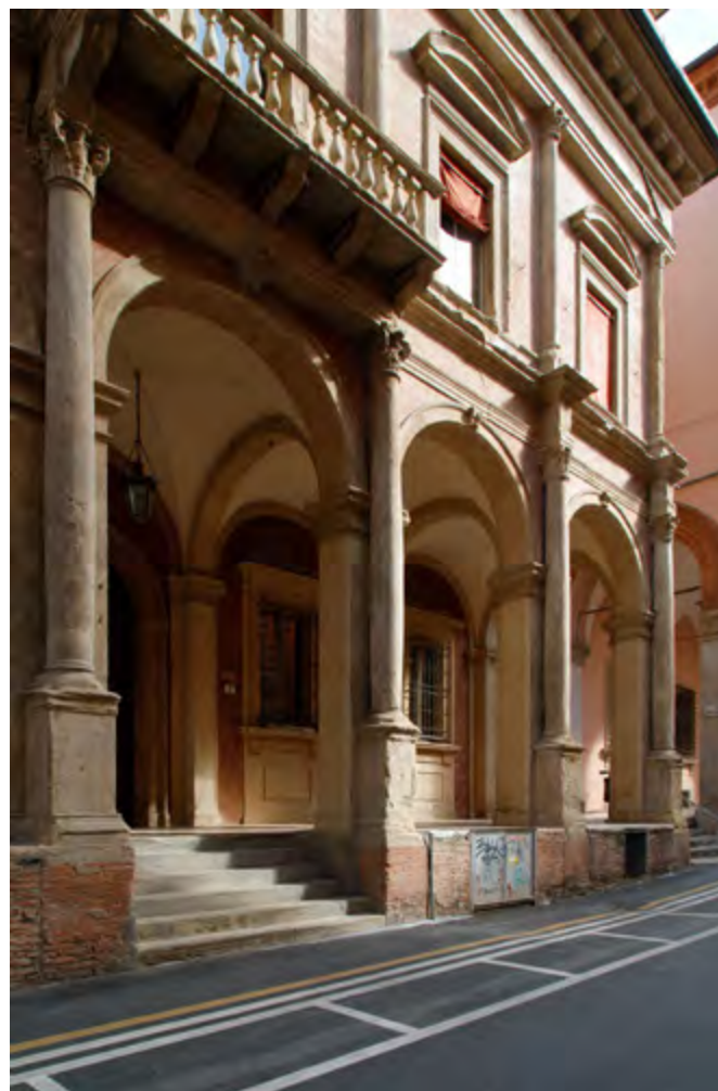
Fig. 40. Portico del palazzo Dal Monte, via Galliera 3.
