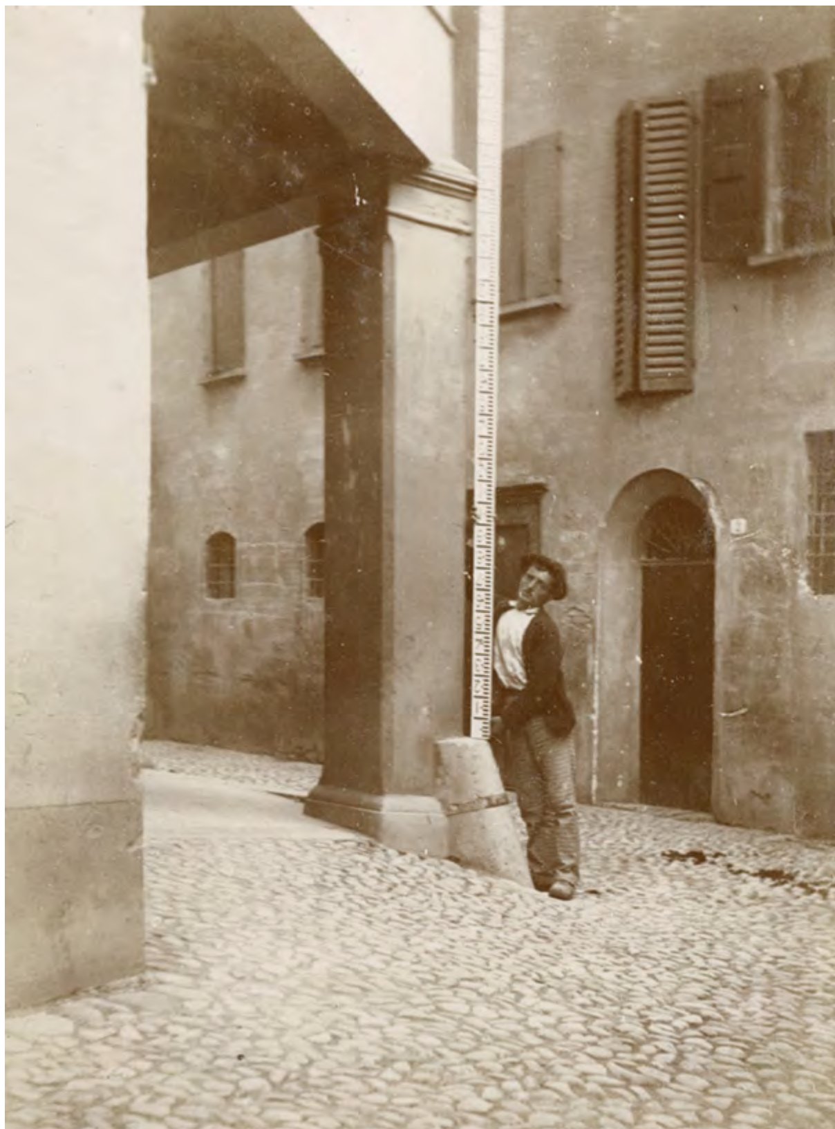
Fig. 63. Livellazioni stradali in via San Bernardino (1896-97).
