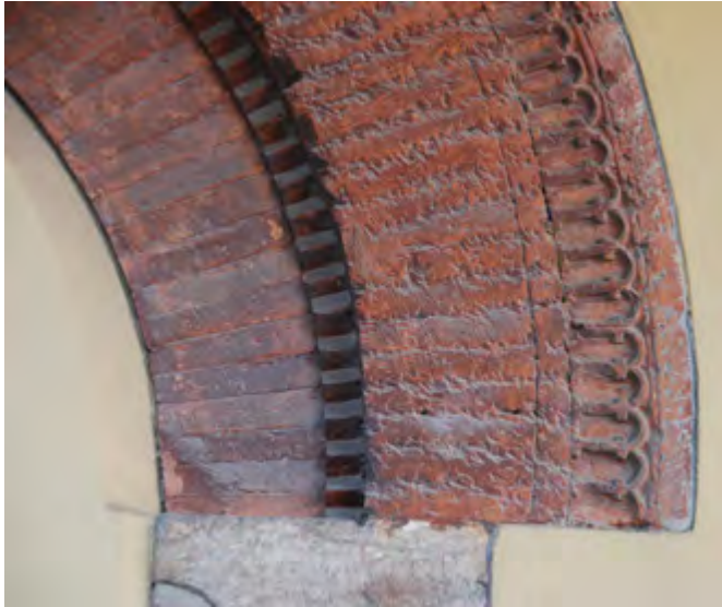
Fig. 12. Particolare di archivolto romanico sotto al portico delle case Tacconi Beccadelli, via Santo Stefano 19.
