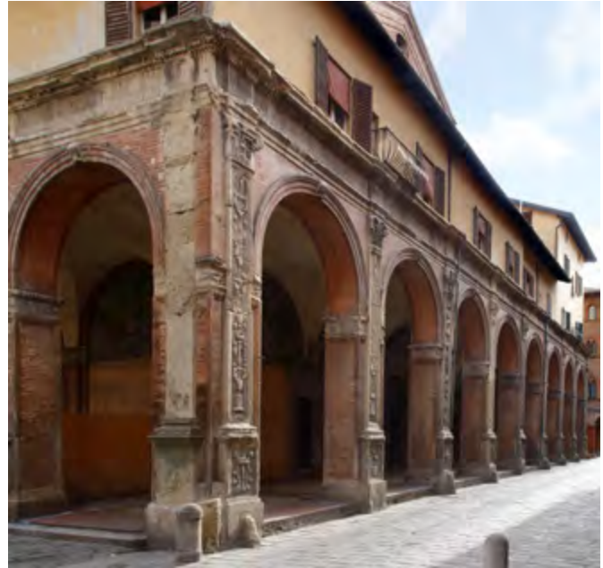
Fig. 38. Portico di palazzo Gozzadini (odierna chiesa di San Bartolomeo), Strada Maggiore 4.
