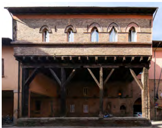
Fig. 4. Casa Grassi, via Marsala 12.
