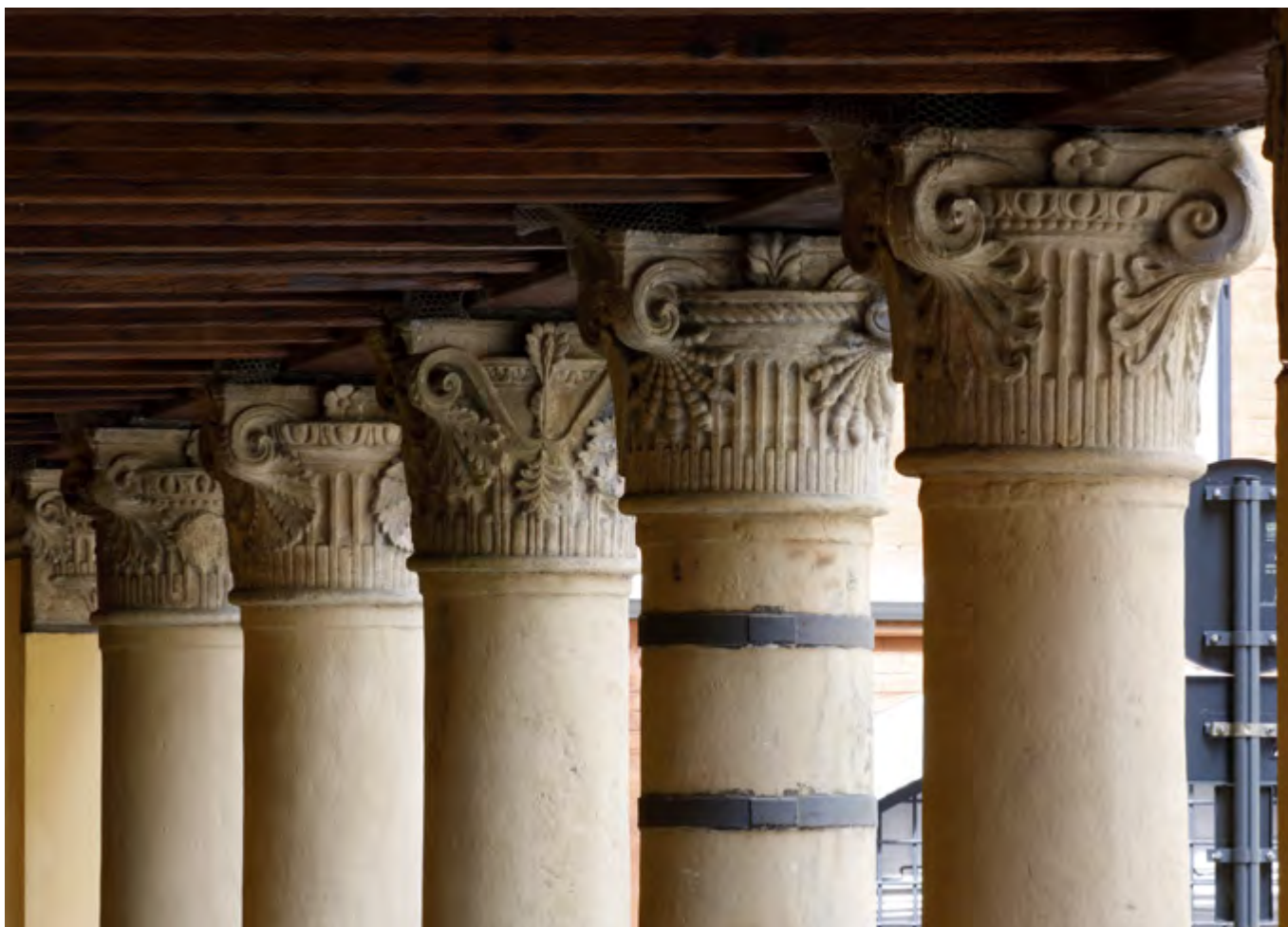
Fig. 28. Particolare dei capitelli del portico della casa in via del Carro 8.
